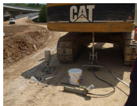
Prova di carico su piastra circolare
