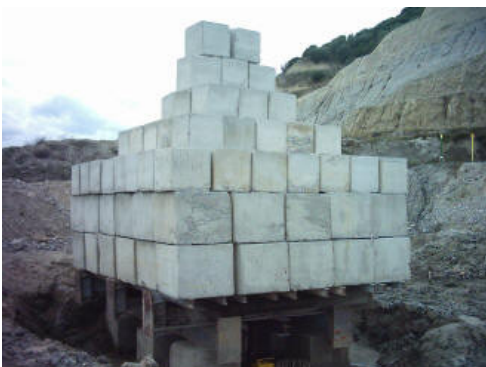
Prova di carico su palo con zavorra di contrasto
